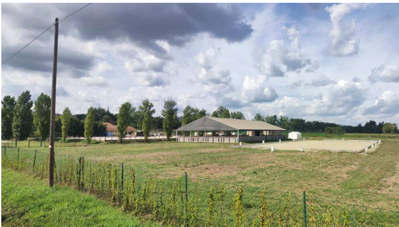
Foto 2 (Torre di Montefalco)
