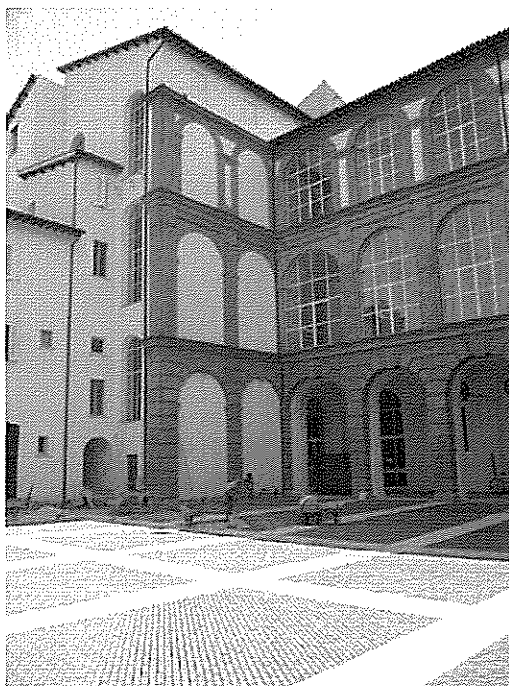
Palazzo Scafali Brunetti Candiotti, vista dal Cortile interno
