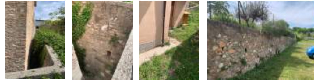
Zona edificio chiesa e piazzale antistante: si noti la presenza di intercapedine perimetrale, bocche di lupo non pervie, discendenti a giorno non raccordati e particolare muro di contenimento di monte
