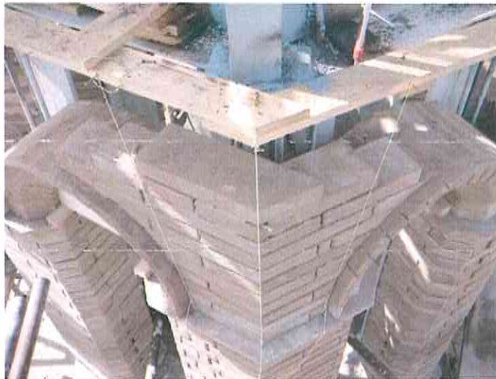
2007 – ricostruzione del torrino di palazzo comunale
