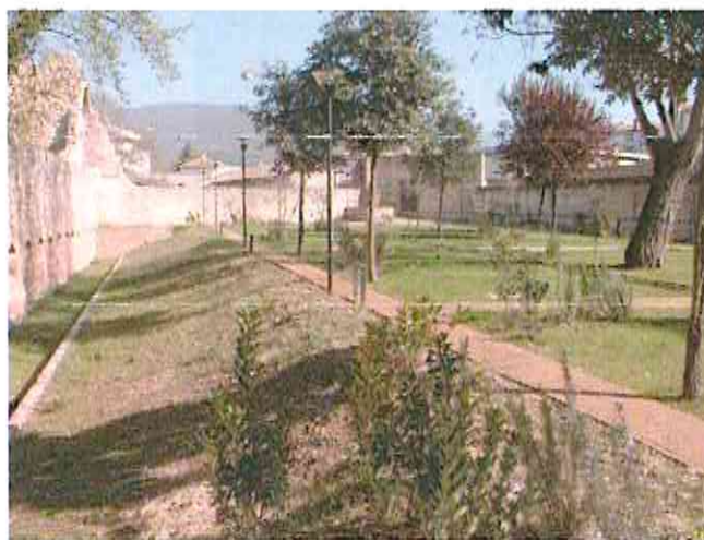
Orti Jacobilli – immagine dei lavori appena completati.
