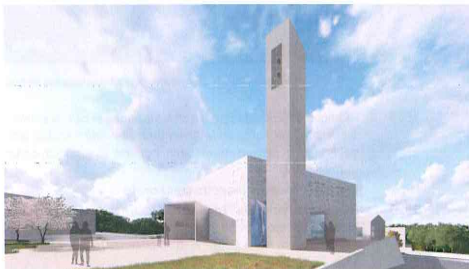
Nuovo complesso parrocchiale di "San Giovanni Battista", l'Aquila (AQ), Pile.
