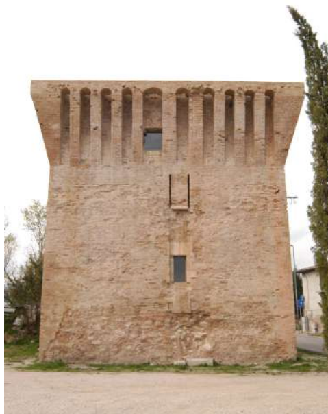
Torre medievale di Montefalco, dopo il restauro
